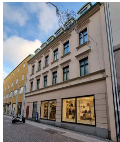
Hus A. Gatufasad mot Drottninggatan utförd som en historisk kuliss.
