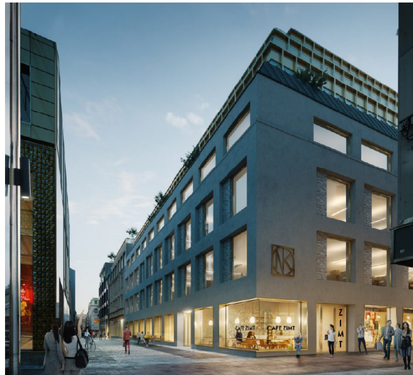
Hus D's karaktär av trevåningsbyggnad försvagas av tillbyggnad, den äldre höjdska- lan kan dock fortsatt avläsas då förlängningen av fasaden görs i indraget läge. Källa: Ahrbom & Partner.
