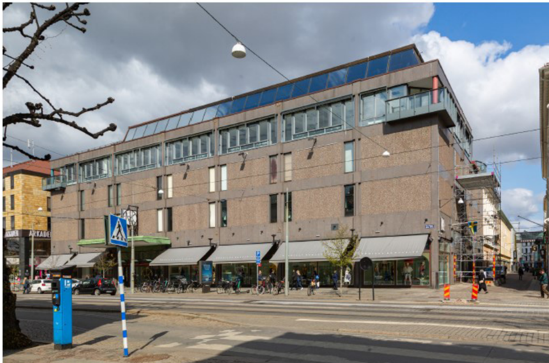
Hus E, huvudfasad mot Östra Hamngatan. Bottenvåningen upptas av skyltfönster och huvudentrén markeras av ett sentida skärmtak. Fasad i våning fyra glasades upp på 1990-talet men i våning 2-3 är den ursprungliga slutna gestaltningen bevarad. På taket finns en ursprunglig takvåning med lutad fasad. Byggnadens höjdskala trappar ner mot kvartersgatorna.
