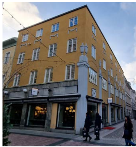
Hus F, fd biograf Odéon. Fasaderna är relativt välbevarade i våning 2-4 med klassicerande dekor. Mot Fredsgatan har bottenvåningen klätts med kolmårdsmarmor.
