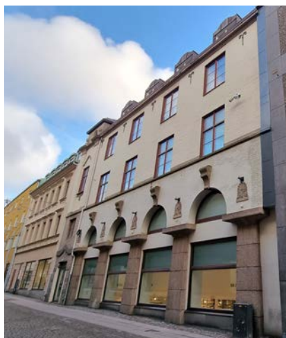
Hus C. Fasad mot Drottninggatan med en till stora delar bevarad karaktär sedan omgestaltningen 1917-1922.
